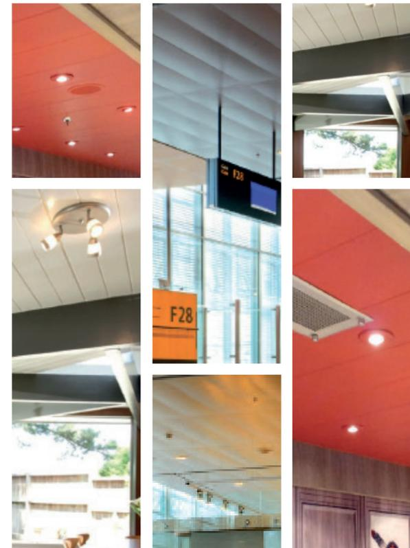
El diseño de las lamas "T" es limpio y elegante, su principal característica es el estar completamente sellado después de la instalación, pero a la vez, permite un fácil acceso al interespacio del techo, plenum, gracias a su fácil apertura. Aporta un plus de seguridad en todas las instalaciones, y con el modelo toscana, la longitud de lama simplemente apoyada en sus lados cortos se alarga hasta los 3.5 mts.
